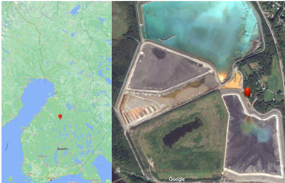
Kuva 17. Säiliöiden sijainti Pyhäsalmen kaivoksella.
